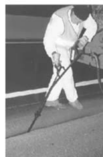
Rys. 4. Układanie kabli wzdłuż dróg w specjalnych wyźłobieniach w asfalcie
