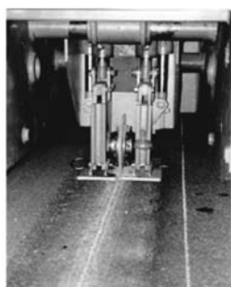
Rys. 4. Układanie kabli wzdłuż dróg w specjalnych wyźłobieniach w asfalcie
