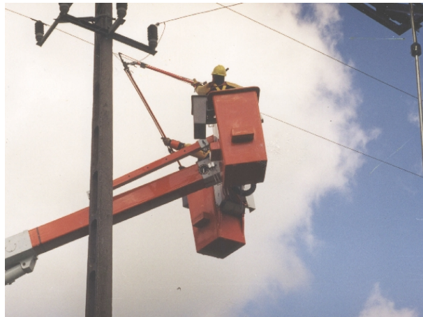
Rys.4. Prace pod napięciem w sieci średniego napięcia
