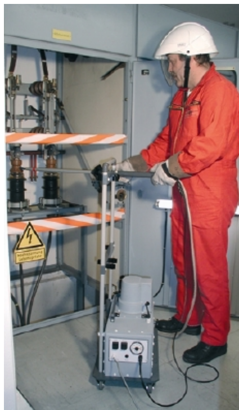
Rys.2 Uzupełnianie syciwa pod napięciem
