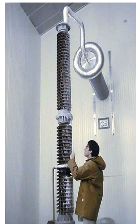
Rys. 4. Wnętrze nowoczesnej komory klimatycznej w laboratorium CIGELE (Industrial Chair on Atmospheric Icing on Power Network Equipment – Univ. du Québec, Chicoutimi, Kanada) do badania napięcia przeskoku izolatorów pokrytych lodem
