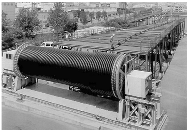
Rys.1. Układanie linii 500 kV XLPE o długości jednego odcinka 1200 m; szerokość bębna 9 m
