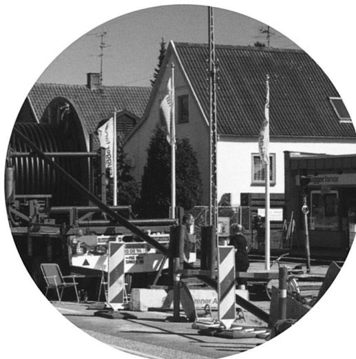
Rys.7. Bęben kablowy o rekordowej średnicy 5 m ustawiony na ulicy stolicy Danii – układanie kabla 420 kV [11]
