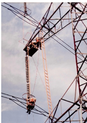
Rys.2. Prace pod napięciem przy wymianie uszkodzonego izolatora na linii 400 kV
