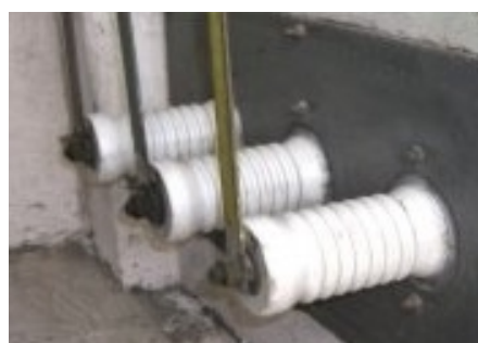
Rys.6. Urządzenie rozdzielcze w stacji transformatorowej po wykonaniu prac - oczyszczeniu
