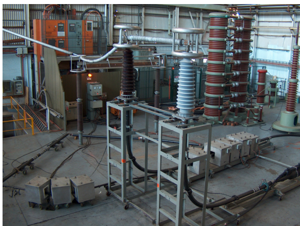
Fot. 2: Próba typu kabla 132 kV, 1600 mm 2 Cu - pętla główna i kontrolna podczas próby nagrzewania cyklicznego, Olex Australia.
