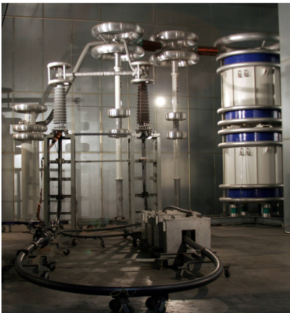
Fot. 1: Próba typu kabla 132 kV, 1600 mm 2 Cu - pętla gotowa do pomiaru poziomu wyładowań niepełnych w Olex Australia.
