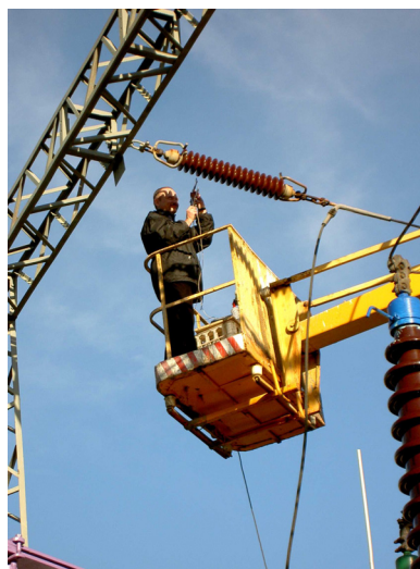
Rys. 1. Pomiary ultradźwiękowe izolatora LP 75/17 w miejscu eksploatacji
