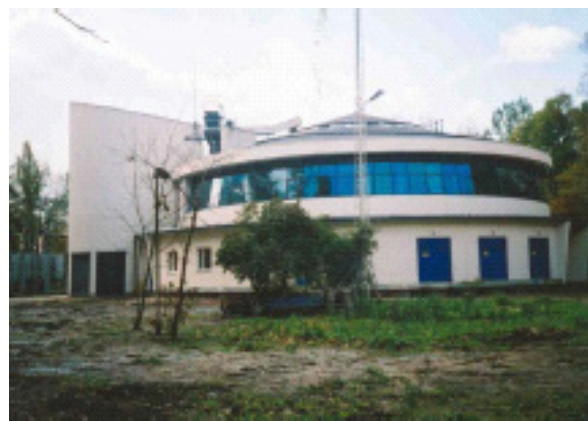
Fot. 4. Stacja 110/15 kV w okrągłym budynku
