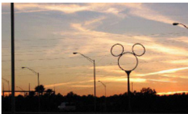
Fot. 3. Stup linii wysokiego napięcia nawiązujący do postaci Myszki Miki
