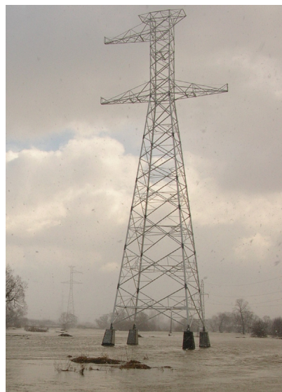
Rys. 1. Sylwetka słupa przelotowego – PI, posadowionego w dolinie rzeki Wisłok
