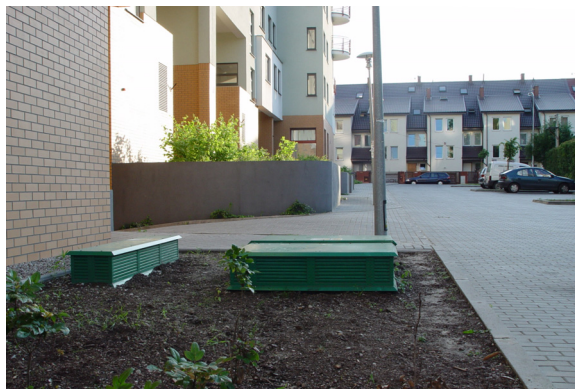
Rys. 9. Widok stacji zagłębionej w ziemi, praktycznie znikome oddziaływanie stacji na otoczenie - Warszawa
