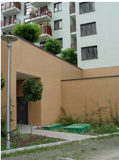
Rys. 12. Osiedlowa stacja podziemna, korzystnie niewidoczna – osiedle w Warszawie
