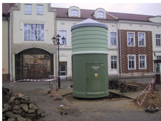
Rys. 3. Stacja w postaci słupa ogłoszeniowego w trakcie montażu w centrum miasta - Rzeszów
