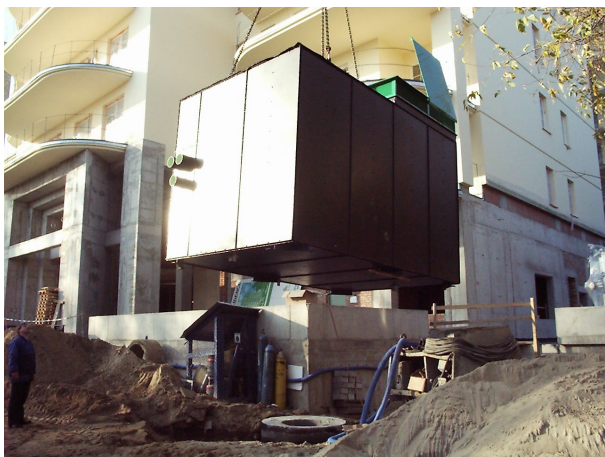
Rys. 13. Operacja posadowienia stacji podziemnej w nowoczesnym budownictwie Warszawy
