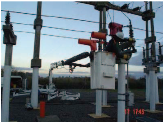
Rys.7. Zautomatyzowany wysięgnik podczas prac pod napięciem [6]
