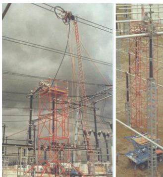
Rys.4. Prace pod napięciem na szynach zbiorczych w wykonaniu przewodowym i rurowym [12]
