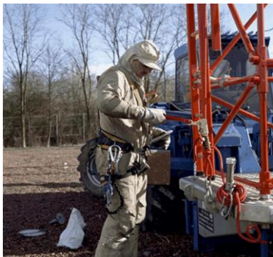
Rys.14 Prace pod napięciem na stacjach WN są możliwe dzięki stosowaniu specjalnej odzieży ekranującej przed wpływem pola elektrycznego [12]
