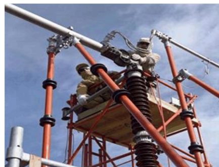
Rys. 8 Wymiana odłącznika pod napięciem [13]
