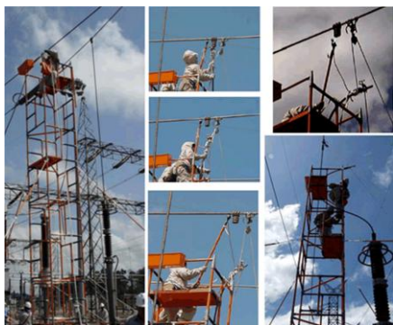
Rys. 10 Prace przy wymianie przekładnika napięciowego z zastosowaniem by-passa [8]
