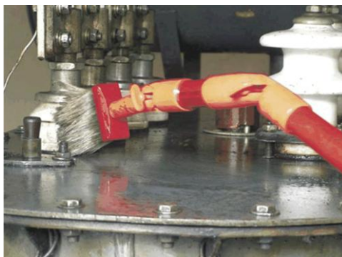
Rys.12 Mycie izolacji nisko i średnio napięciowych na mokro [8]
