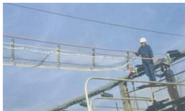
Rys.2. Prace przy wymianie szyn zbiorczych pod napięciem [12]
