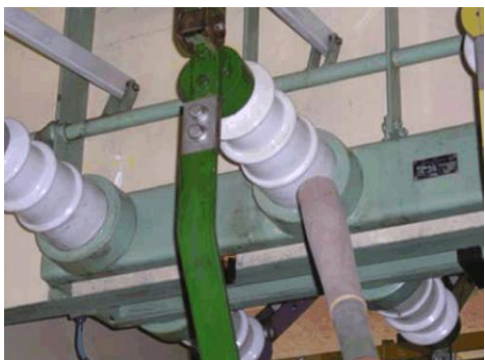
Rys.11 Czyszczenie izolacji urządzeń rozdzielczych na sucho [8]
