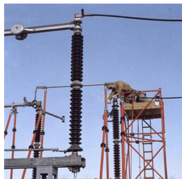
Rys. 7 Prace pod napięciem przy biegunie (kolumnie) odłącznika [13]
