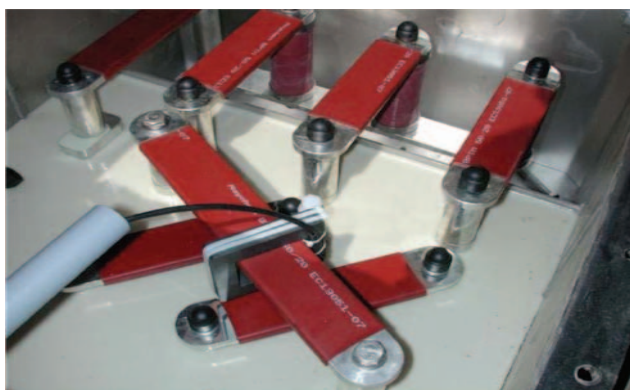
Rys.2. Sondy indukcyjne wnz umieszczone na połączeniach typu „cross-bonding”
