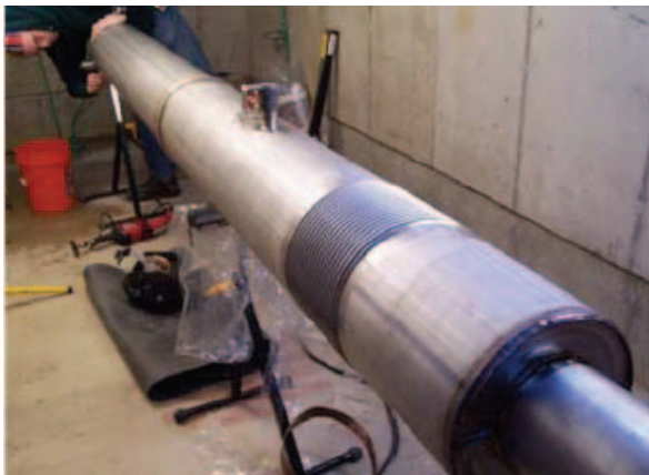
Rys. 10. Montaż mufy kabla HTS [9]
