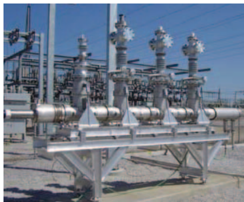
Rys. 9. Trójfazowe zakończenie kabla [9]
