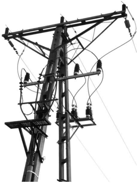
Rys. 2. Stanowisko słupowe z zejściem kablowym po wymianie odłącznika
