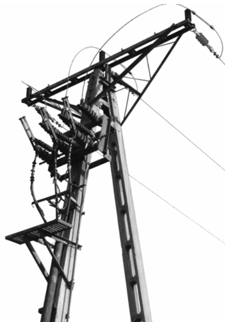
Rys. 1. Stanowisko słupowe z zejściem kablowym przed wymianą odłącznika
